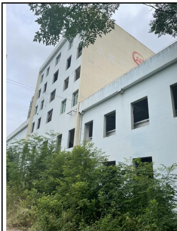
主厂房及办公楼
