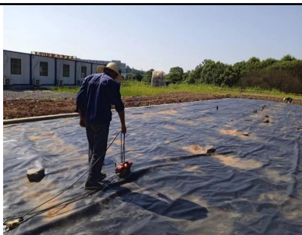
修复区土壤堆存区覆膜
