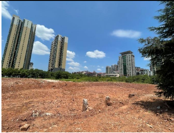
清挖完成后基坑北侧
