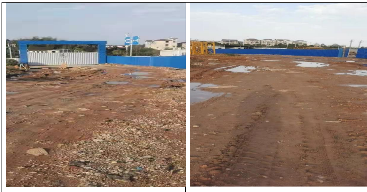
图 4.3-6 兆丰渣土场建设前现场照片
