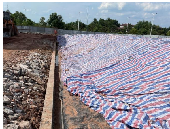
土壤暂存区排水沟+土壤堆体覆盖
