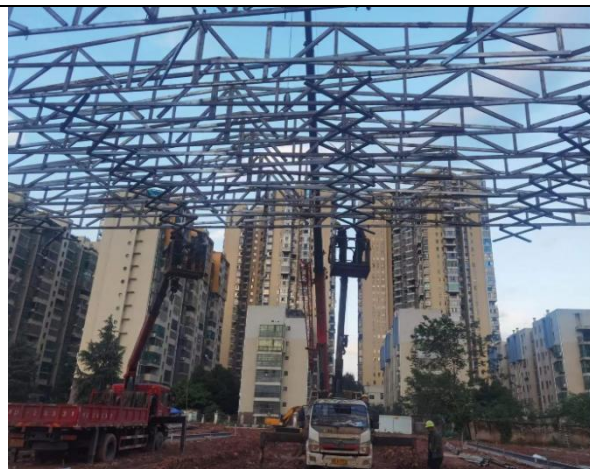
开挖区大棚建设 1
