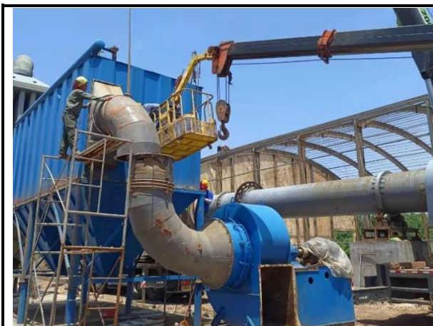
修复区设备安装
