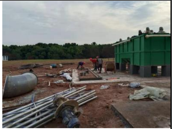
废水处理设施安装
