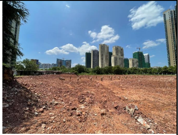
清挖完成后基坑南侧
