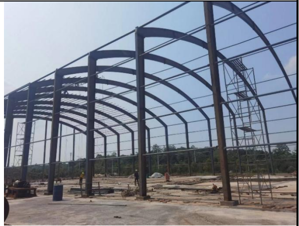
修复区负压大棚安装
