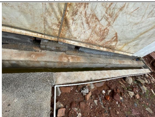
负压大棚外排水沟
