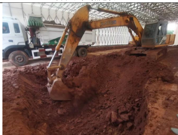
污染土壤开挖
