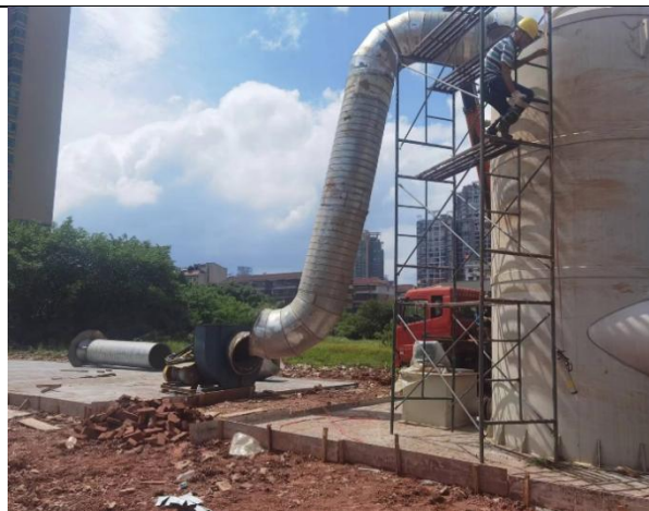
开挖区尾气处理设备安装
