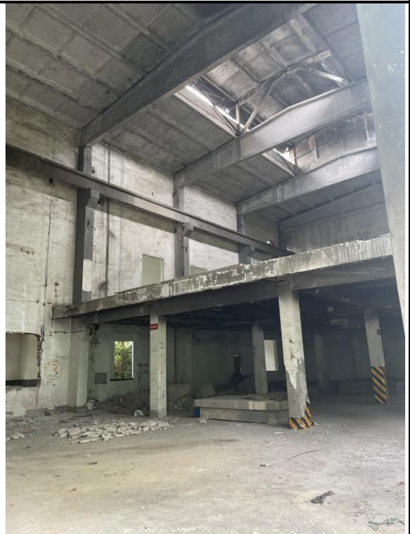
主体厂房锌粉生产车间
