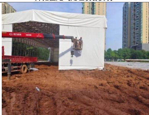
开挖区大棚建设 2
