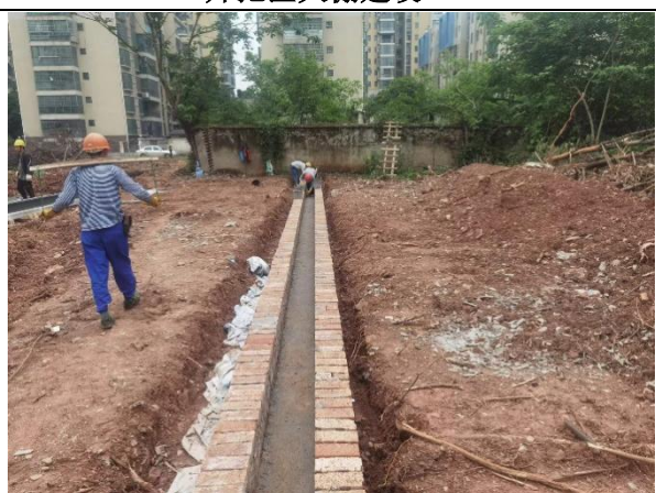
开挖区排水沟筑砌
