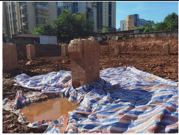
水泥墩清洗完成、废水收集
