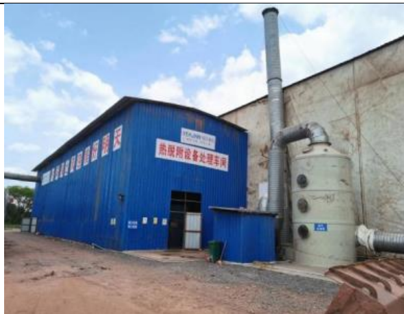
热脱附设备处理间钢棚搭建
